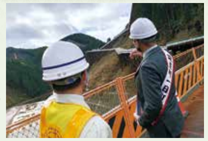
ダム工事現場視察の様子
